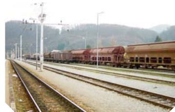
Vlak, tirnice, električni vodniki
